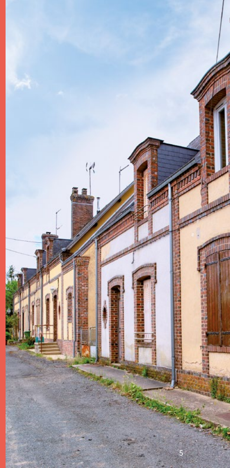
Une série de logements ouvriers à la verrerie de la Pierre.
