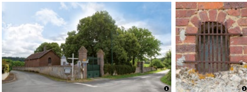
Le carrefour de la Croix Dolonnier 1. Une petite baie des communs de la maison de la Croix Dolonnier 2.
