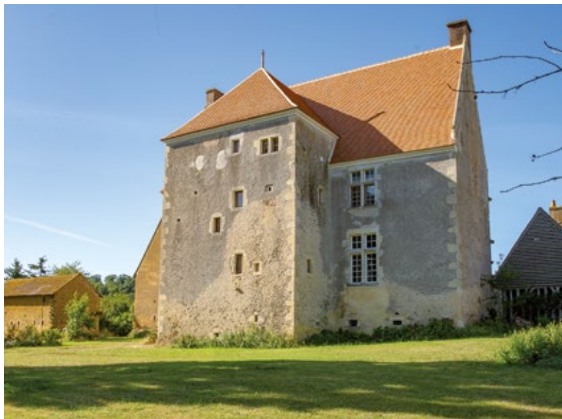
La façade postérieure du logis de la Cour flanquée de son pavillon.
