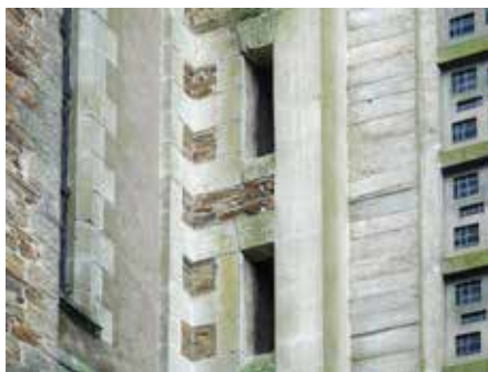
Détail de la transition entre la façade ancienne (partie en pierre apparente et partie enduite) à gauche, une portion de mur de l'ancien clocher au centre, et la paroi
