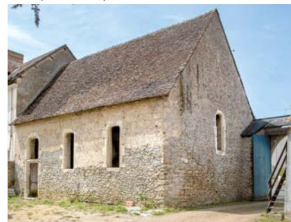
La chapelle de l'hôpital, côté cour.
