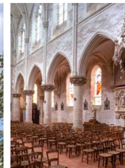
Les piliers de la nef.
