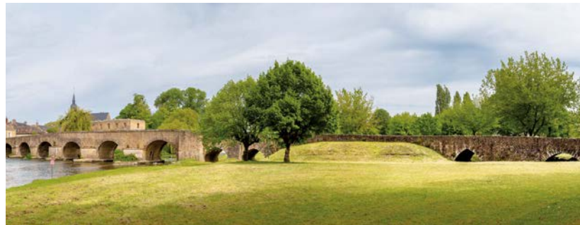
Le vieux pont sur l'Huisne, côté aval.
