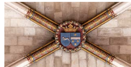
Un détail d'une clé de voûte aux armoiries des Nicolaÿ dans la chapelle de l'hospice.
