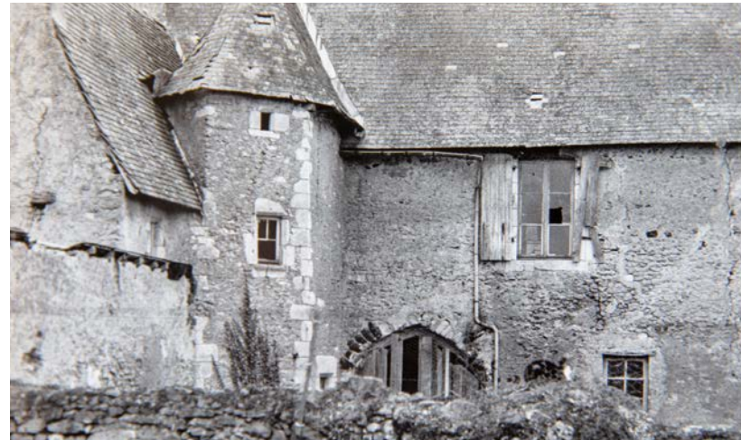
La maison des Piliers photographiée avant sa démolition (collection particulière).
