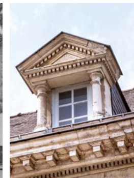
Une lucarne et une corniche ouvragées dans la rue de l'Église.
