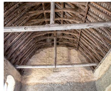
La charpente de la chapelle.
