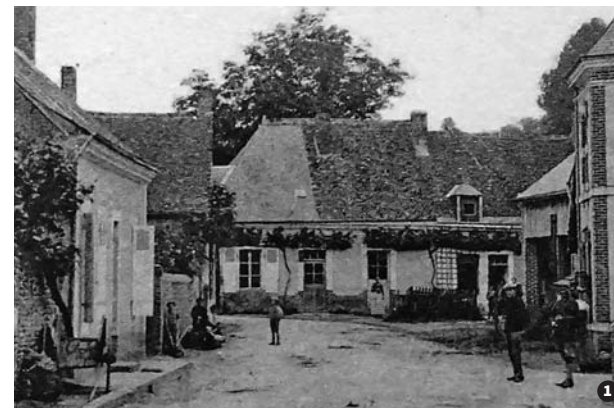
1 Les "Grandes Maisons" au début du XX e siècle. 2 Bâtiment agricole, rue Marie-Virginie Vaslin.
