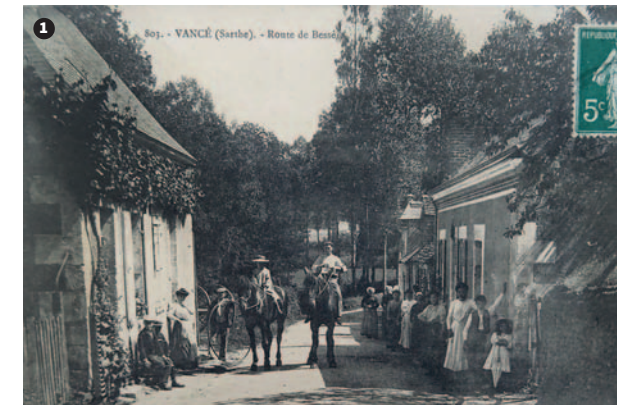
Rue du Vallon : 1 la rue au début du XX e siècle, 2 la maison n°4.
