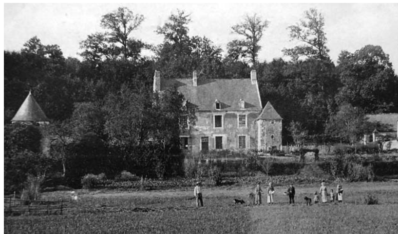
Cogners, la Loutière avant la suppression de l'étage du logis en 1956.
