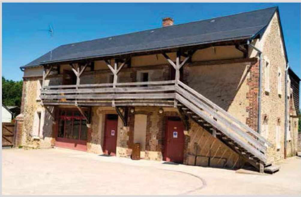
Le gîte, côté court
