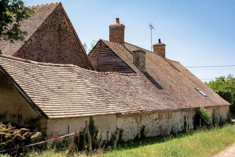
Façade arrière des bâtiments du Four.
