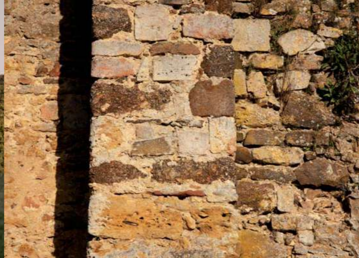
Détail des matériaux de construction de l'église montrant la variété géologique de Saint-Michel-de-Chavaignes.
