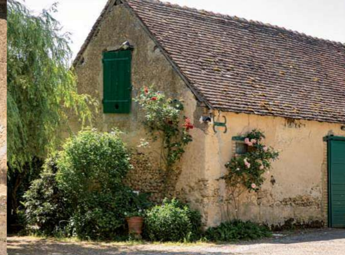
Les Caves, ancienne dépendance agricole.
