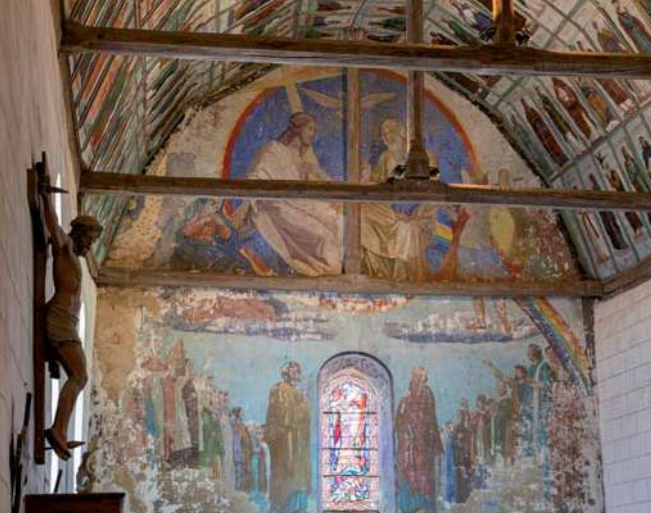
Le mur-pignon occidental et ses peintures réalisées entre 1860 et 1865.
