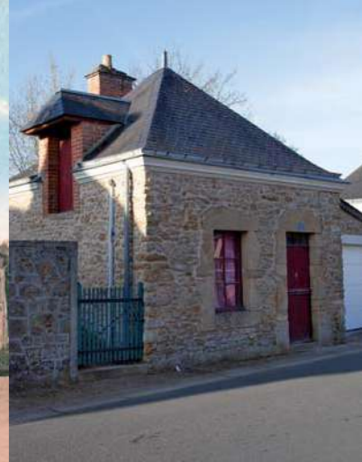
Fournil au n°5 rue de la Gare.
