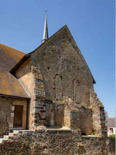
Le pignon Est de l'église présentant des baies romanes bouchées et la trace d'un changement de pente de la toiture.
