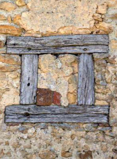
Détail d'une ouverture bouchée à l'arrière du Four.
