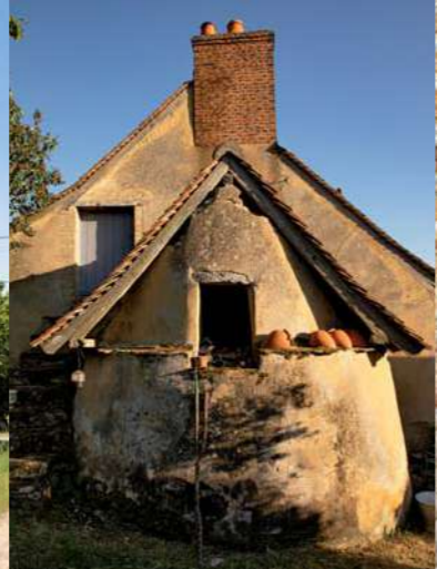
Four à pain au pignon de la maison de la Haute Épine.
