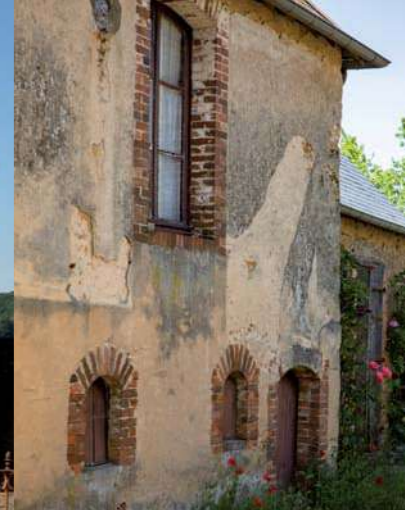
Maison sur soubassement de cave à l'angle de l'impasse de la Violette.
