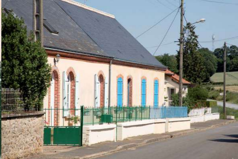
Maisons n°5 et 7, rue de Coudrecieux.
