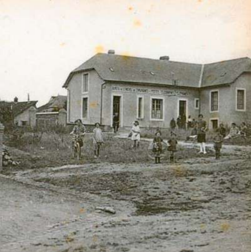
Ancien presbytère transformé en bureau de Poste dans les années 1920.
