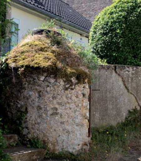
Ancien puits commun, chemin du Couvent.
