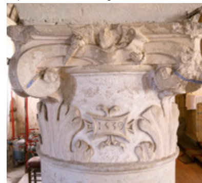
Le pilier Renaissance de l'église daté 1539.
