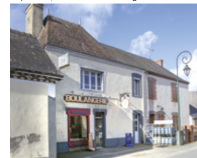
Le pavillon, actuellement boulangerie.
