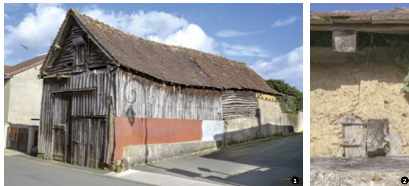
Une remise en bois et torchis rue des Châteliers ❶. Un détail de mise en œuvre en bois et torchis ❷.
