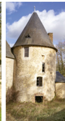
La grosse tour d'angle du XVI e siècle.
