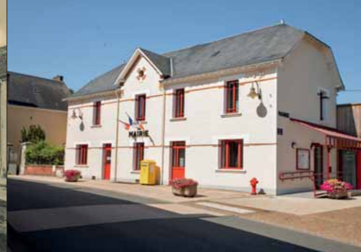
La mairie depuis ses derniers aménagements en 2018.
