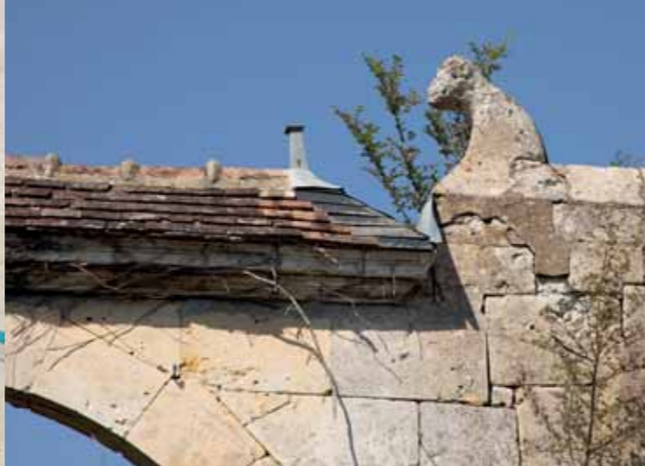
Détail du porche d'accès au château.
