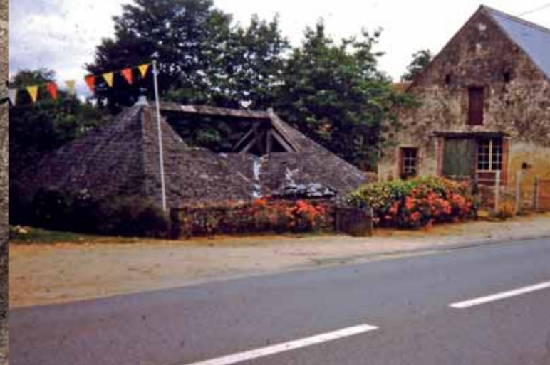
Le lavoir avant sa destruction à la fin des années 1980.
