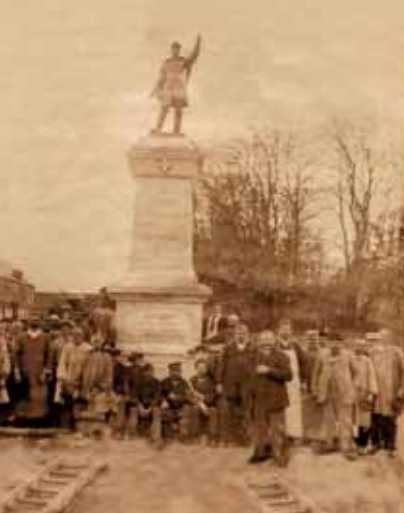
La fin du chantier de construction du monument aux morts de la guerre de 1870.
