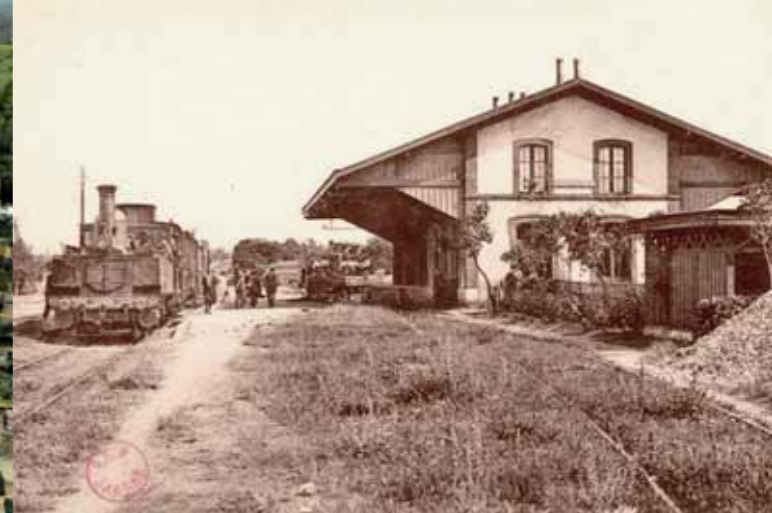
La gare de Thorigné au temps de la ligne de chemin de fer Mamers - Saint-Calais.
