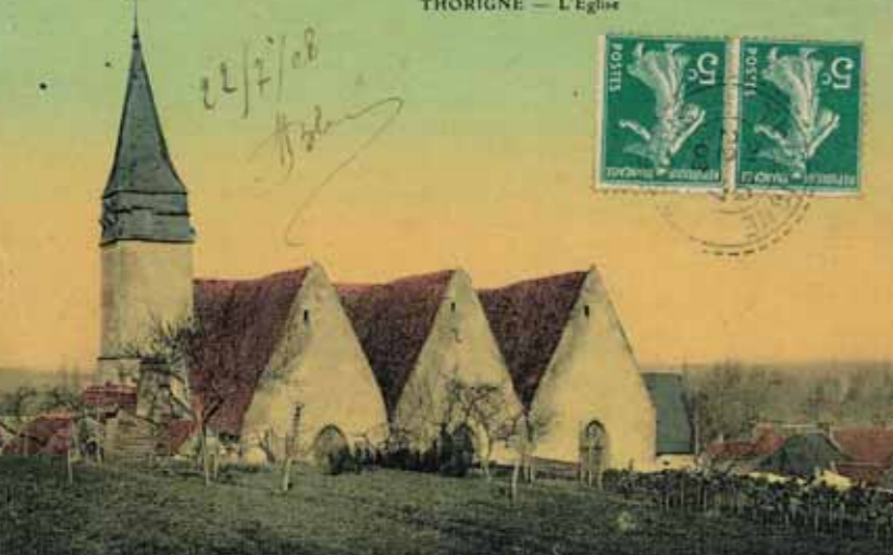
Vue sur l'église depuis le Nord.
